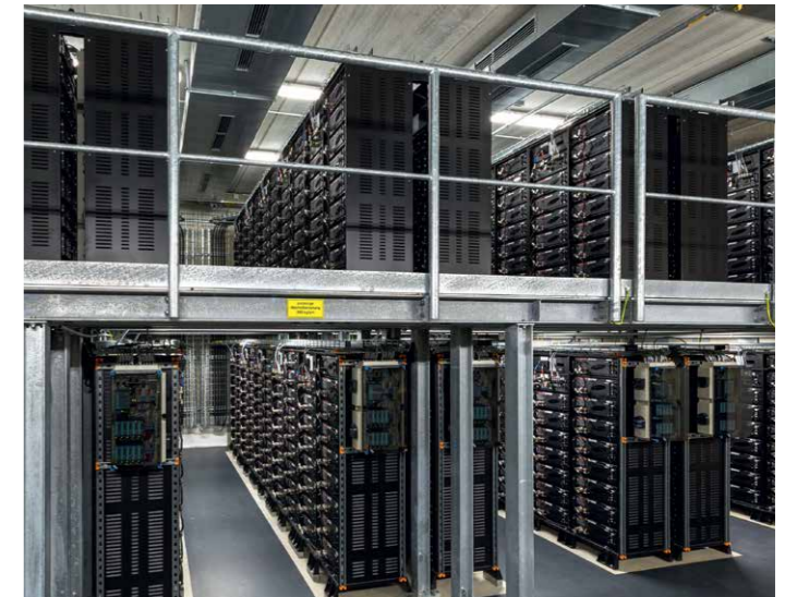
Batteries de stockage Schwerin: Vue intérieure de la salle des accus. Illustration : WEMAG AG
